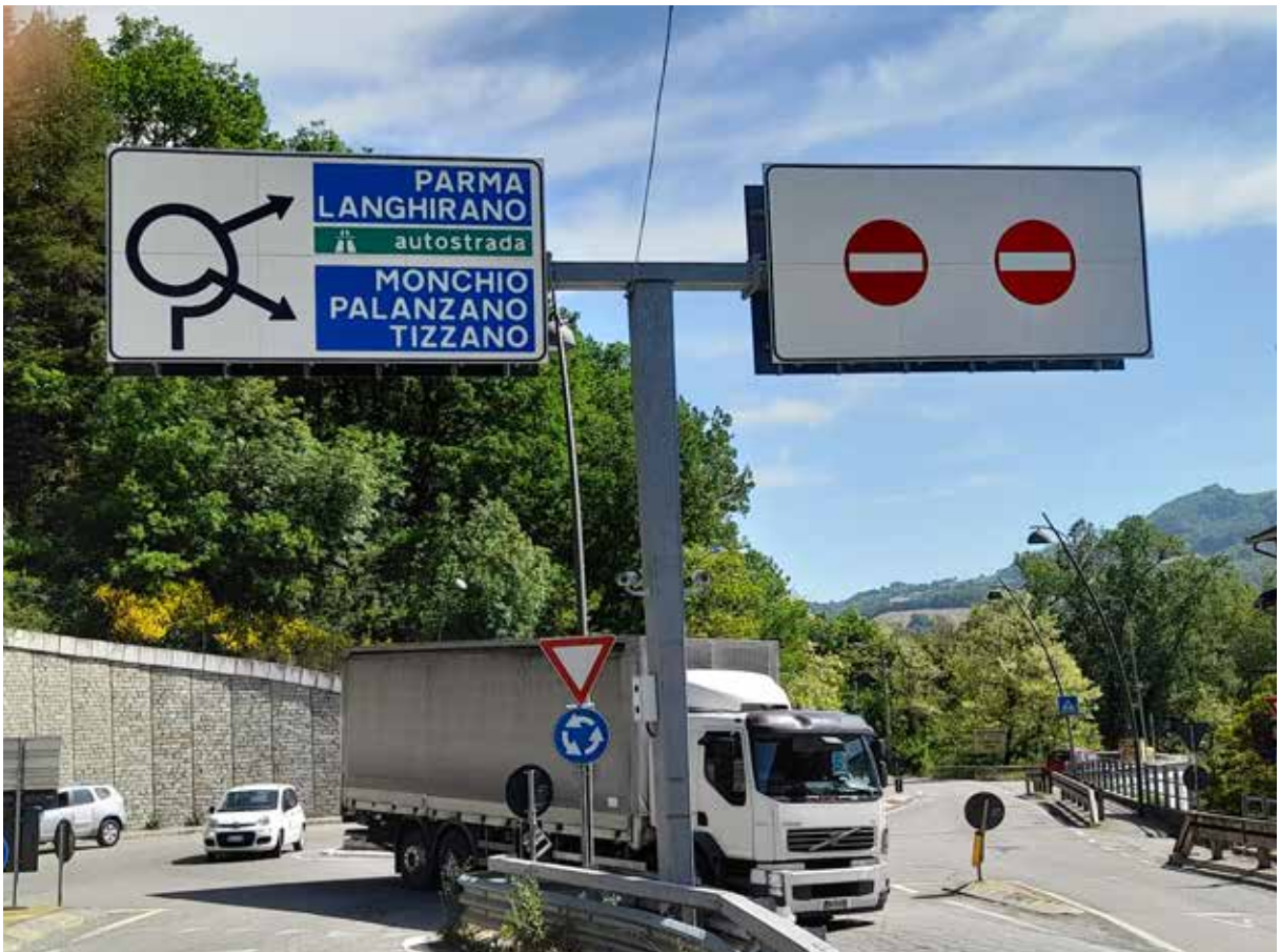
Segnaletica di preavviso: irregolarità per eccesso di informazioni, errata impaginazione, difficile comprensione schema dell'intersezione
