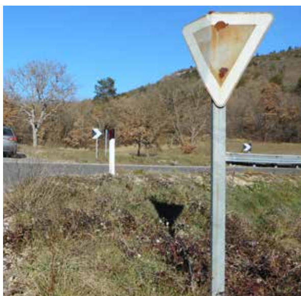
Assenza di manutenzione in violazione dell'articolo 14, comma 1, del Codice della Strada
